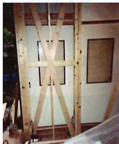
片側を閉鎖し、両筋交いを入れて壁にしました
