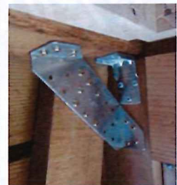
釘打ちされていた筋交いの接合部を筋交いプレートに交換し、ガッチリと固定します。
