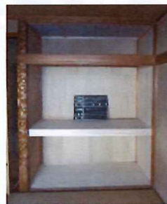
仕上げ材を施工し、元の姿にします
