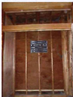
押し入れの下地材をはがします
